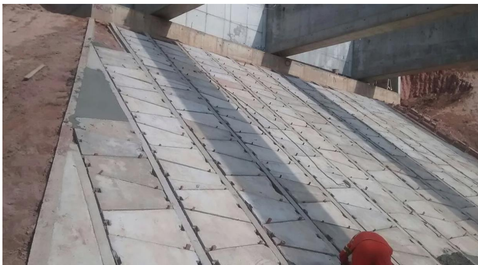
Figura 7.43 - Proteção com placas pré-moldadas (Gerutti, 2017)
