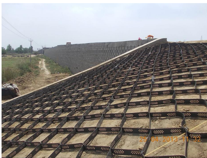
Figura 7.46 - Proteção de talude com Geocélulas - StrataWeb (Geosoluções, 2013)
