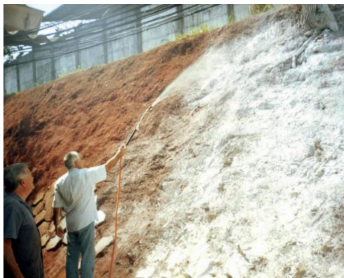
Figura 7.44 - Aplicação da calda de cal com pulverizador motorizado (Téchne, 2011)
